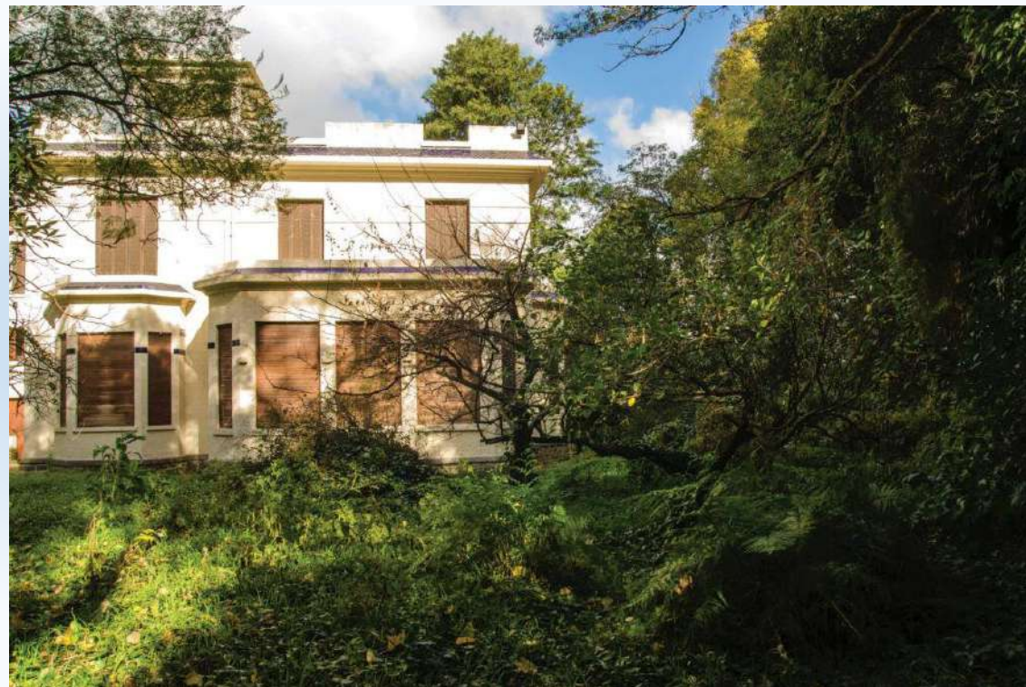
Vista de la casa desde el jardín (Bello y Reborati, 1918, con ampliación en 1928).
